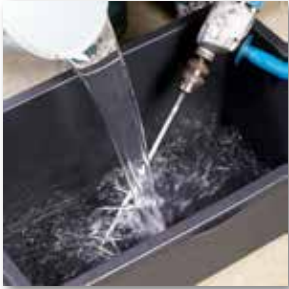
Unterbau, Tragschichten und Bettung vorbereiten. Anschl. 5 bzw. 7 l Wasser vorlegen
