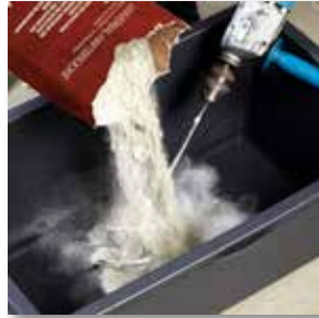
bauline Universal-Haftbrücke hinzufügen und homogen anrühren
