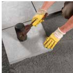
Verlegung „frisch in frisch“
